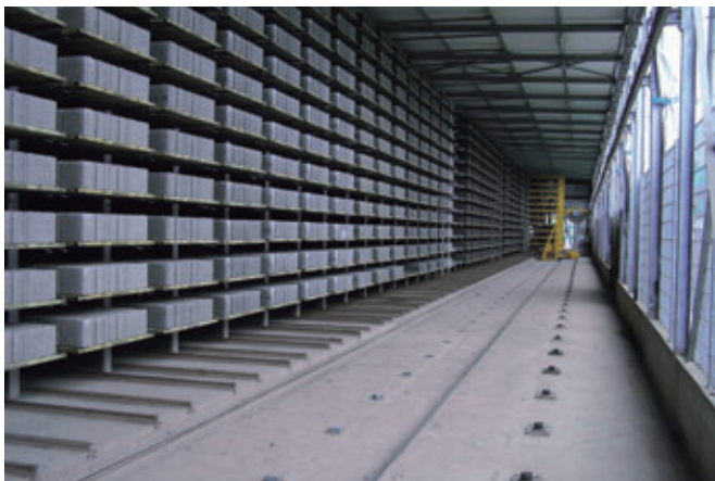
Chambre de séchage avec 15.000 planches Assyx Duroboard
