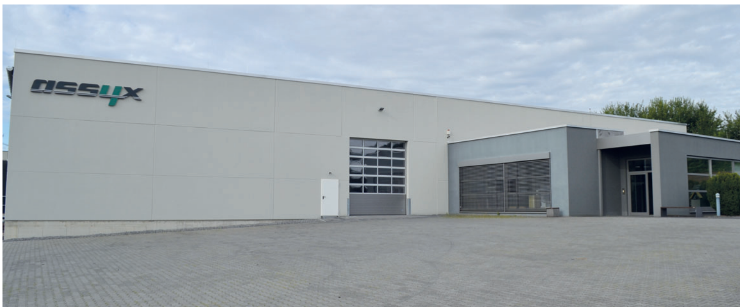
Une seconde aile a été ajoutée au hall de production existant.
