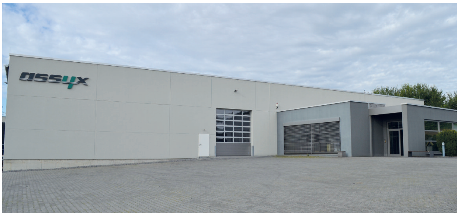
Do istniejącej hali produkcyjnej dobudowano drugą nawę.
