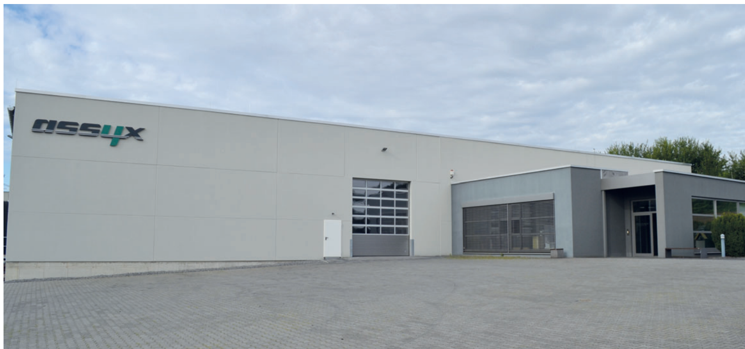
Foi construída uma segunda nave de galpão no galpão de produção já existente.
