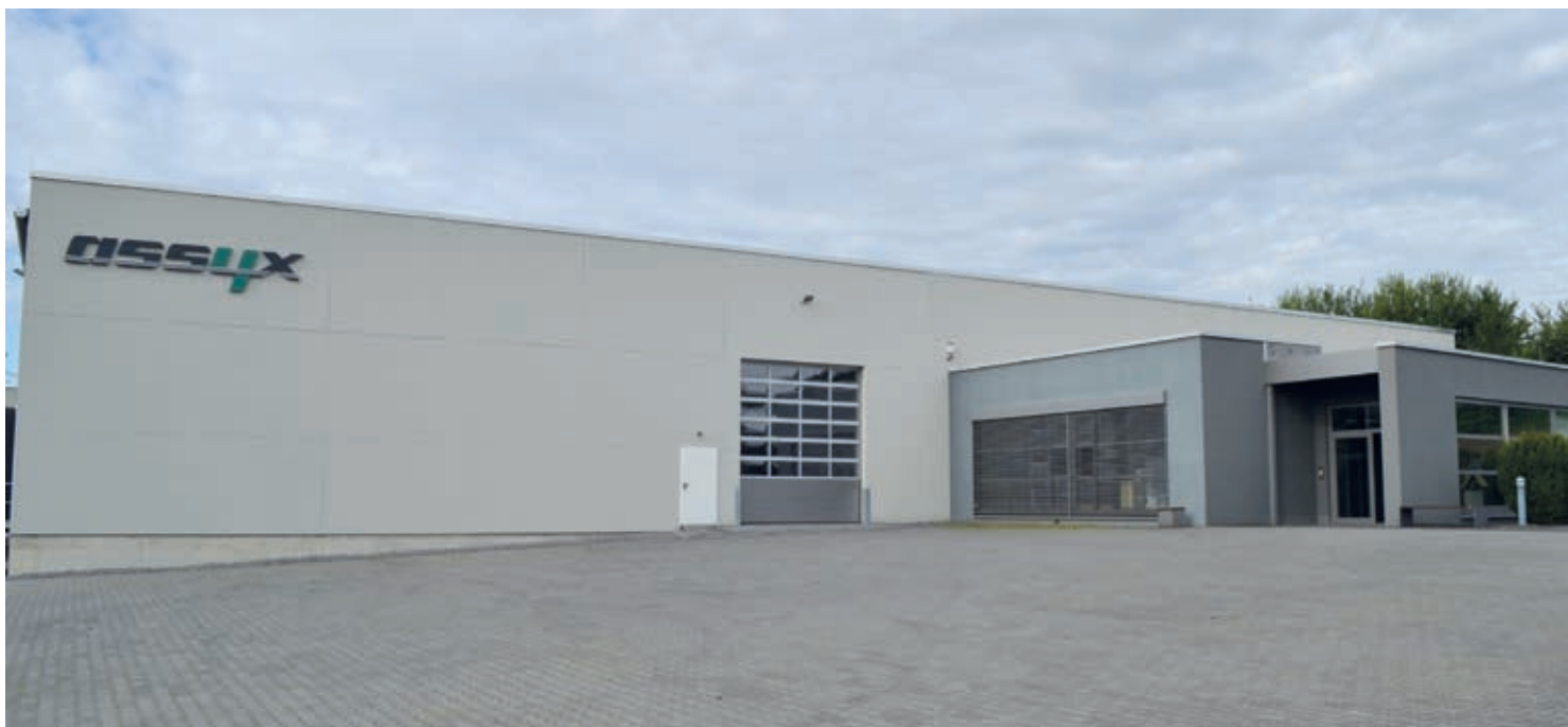
К имеющемуся цеху был пристроен дополнительный пролет
