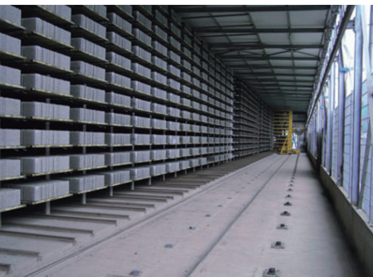
Cámara de secado con 15.000 Assyx Duroboards
