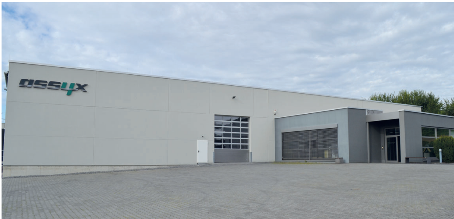
A la nave de producción existente se le ha añadido un segundo módulo.
